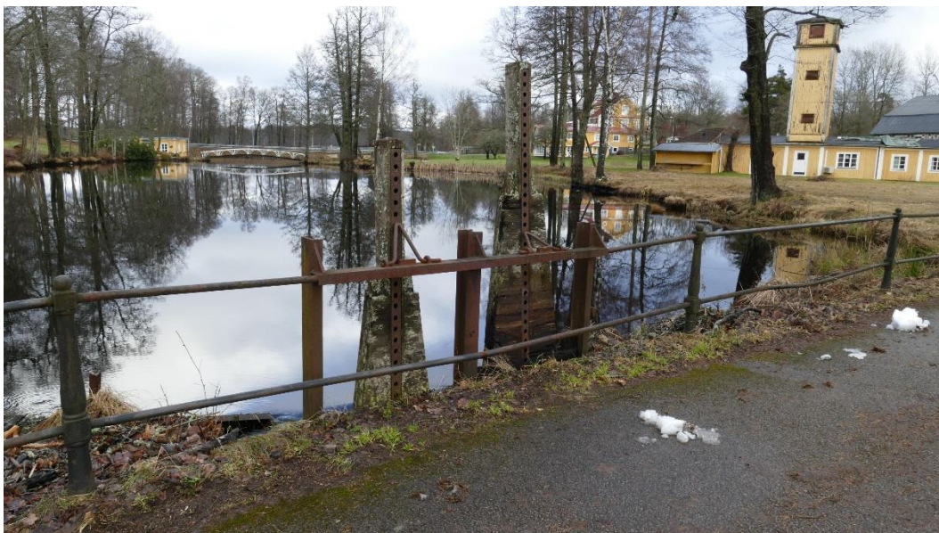
Figur 6. Bruksdammen och dämnet. Utskovspartiet som syns i bilden leder till till en stensatt utloppskanal. Foto Sweco, 2018
