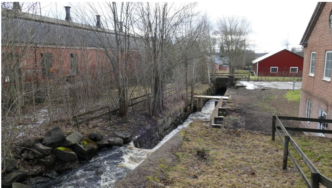
Figur 10. Området direkt nedströms dämnet. Till vänster syns byggnaden med fiskodlingen. I direkt anslutning till denna byggnad gick den tidigare tuben till vattenkraftverket. Vattnet från Bruksdammen rinner i en stensatt kanal.
