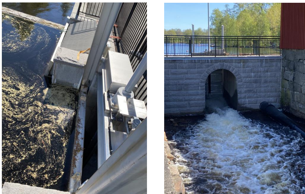
Figur 17. Bilder på ombyggt utskov uppströms (till vänster) och nedströms (till höger) ifrån (Sweco, 2021)
