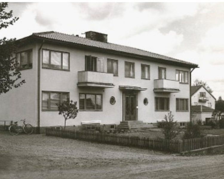
Kommunhuset i Norrhult från 1935. En strikt funktionalistisk skapelse till skillnad från Folkets Hus som byggdes nästan samtidigt. Foto: Nottebäcks hembygdsförening.
