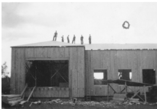
En suddig bild från 1936 där fotografen vill uppmärksamma att taket just lagts på byggnaden, taklagskransen är nämligen rest.
