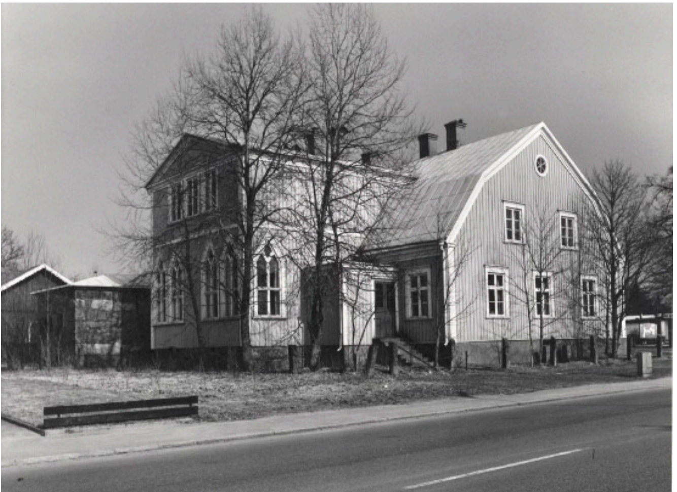
När bilden togs 1981 hade tingshuset stått oanvänt under många år. Plåttaket från 1898 ersattes med betongpannor något år senare. Hörnentrén leder till häradstjänarens bostad. Foto: Smålands museums fotoarkiv.
