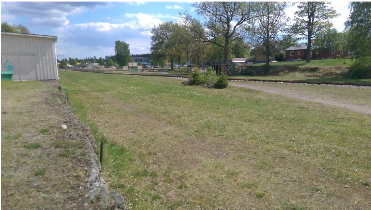
Bild tagen längst söder i planområdet. Här syns tydligt hur berget sprängts till förmån för banvallen.
