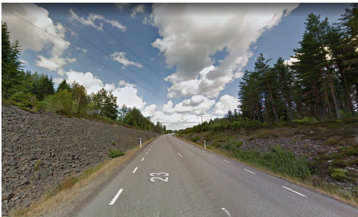
Figur 14: Vy österut från väg 23/37 i västra delen av området. Planområdet till höger i bild. Vägen skär genom den blockrika marken, luftledningen korsar vägen och skapar en korridor med lågväxt vegetation. (Google Street view, inhämtat 2019-04-08)
