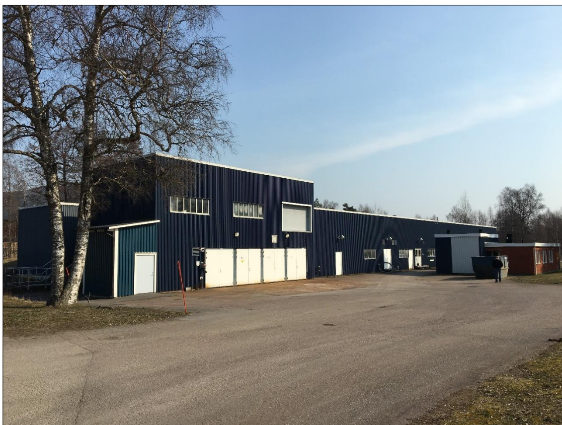
Figur 5.1.1.1: Åseda avloppsreningsverk och intilliggande personalbyggnad
